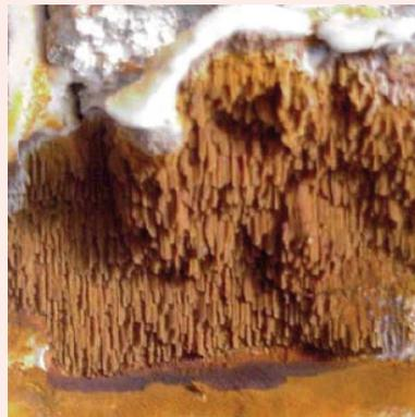
Même si les fondations n'ont pas d'infiltrations, la mérule peut attaquer du bois sec, car elle peut se nourrir de l'humidité contenue dans l'air ambiant.
